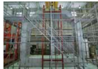
○試験体設置状況1
