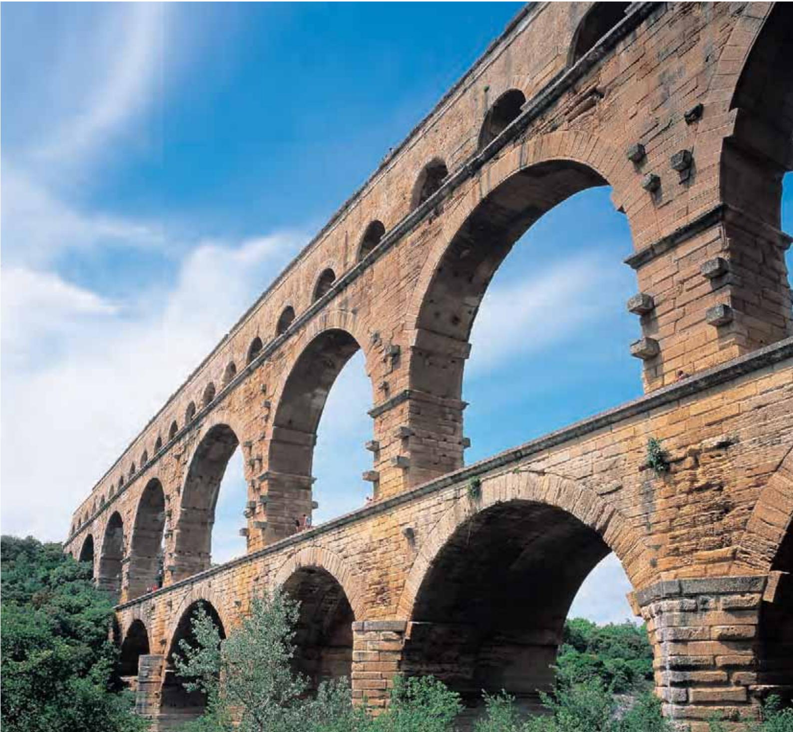
フランスプロヴァンス地方のポンデュガールの水道橋
